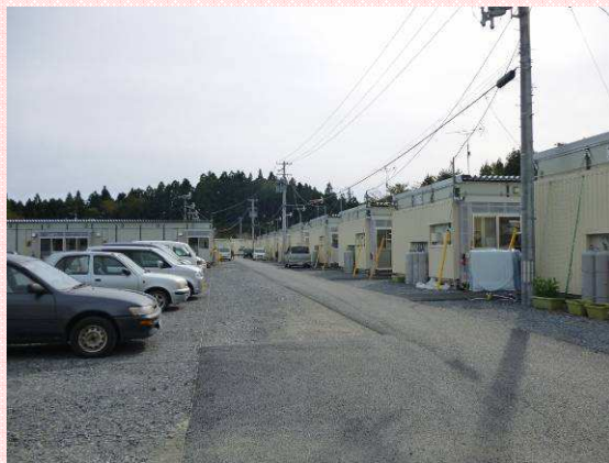
写真③ 仮設集合住宅。津波の被害が無かった学校の校庭や山の上の空き地などに建っている。
